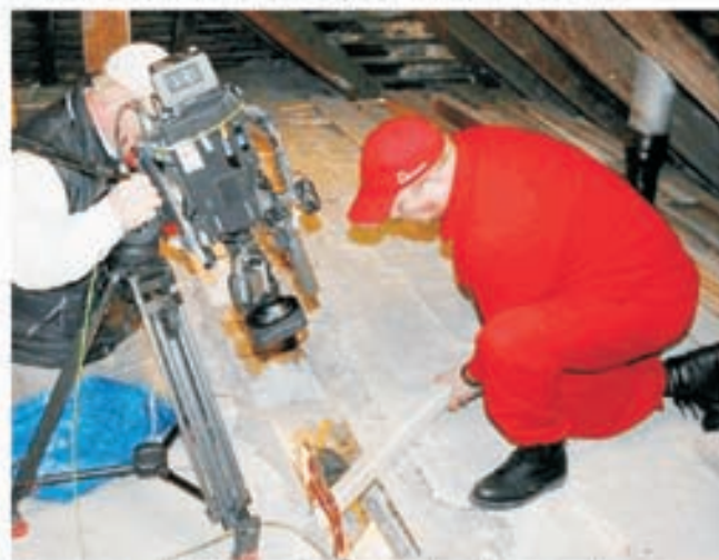
Při natačení potrubí Rady ptáka loskutáka - zateplení dutiny trámového stropu
