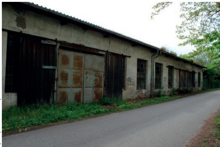
Bývalé provozní budovy
