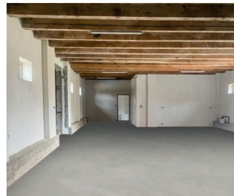
Tělocvična je ve fázi dokončovacích prací.
