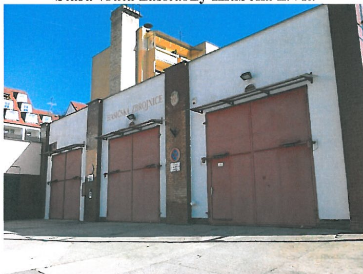
Stará vrata hasičárny Hluboká n.Vlt.
